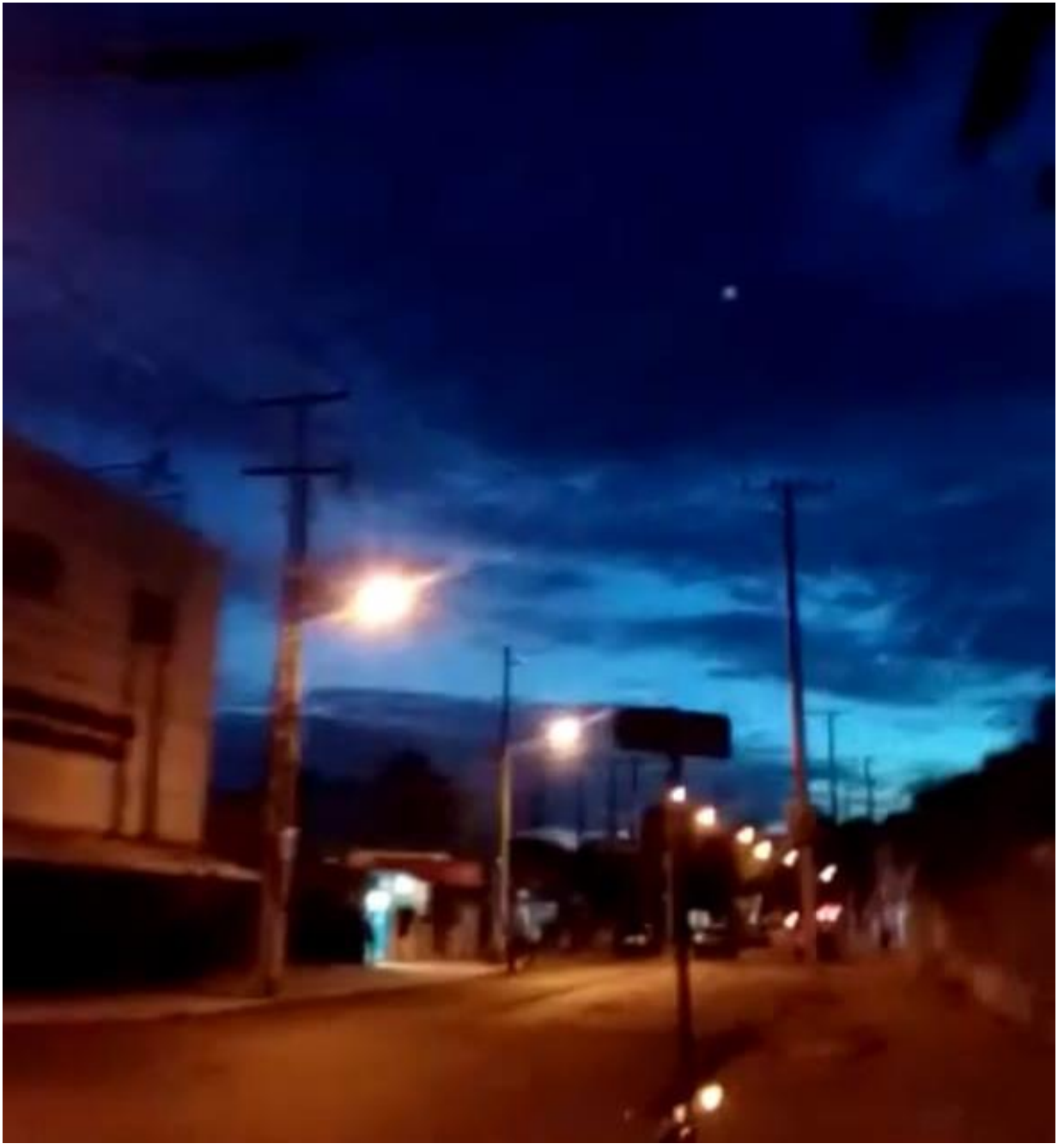
Gestión de la iluminación del entorno del CEMADOJA para mejorar la visibilidad y seguridad
